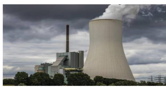
Une centrale thermique
